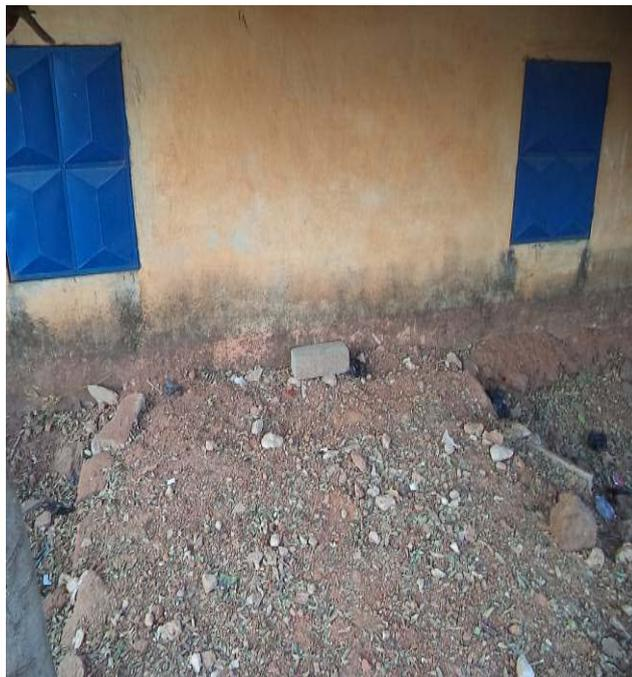
B5 : Traces d'inondation au niveau fenêtre d'un bâtis
